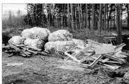
Vor dem Rückbau wurde das Gebäude entkernt. Holzlatten und Fensterrahmen wurden aussortiert.
